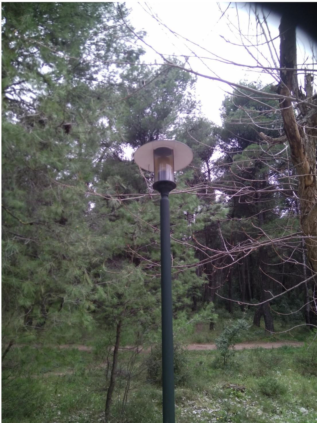
ΦΩΤΟΓΡΑΦΙΑ 13 (Είδη Υπομήματος Γ3, Άρθρο 13) ΦΩΤΙΣΤΙΚΟΥ ΣΩΜΑΤΟΣ ΚΕΦΑΛΗΣ ΑΛΟΥΜΙΝΙΟΥ ΜΕ ΑΤΣΑΛΙΝΟ ΚΑΠΕΛΟ ΓΙΑ ΛΑΜΠΤΗΡΑ ΤΥΠΟΥ E27 LED ΠΕΡΙΒΑΛΛΟΝ ΧΩΡΟΣ ΓΗΠΕΔΟΥ ΔΗΜΟΤΙΚΗΣ ΕΝΟΤΗΤΑΣ ΔΡΟΣΙΑΣ
