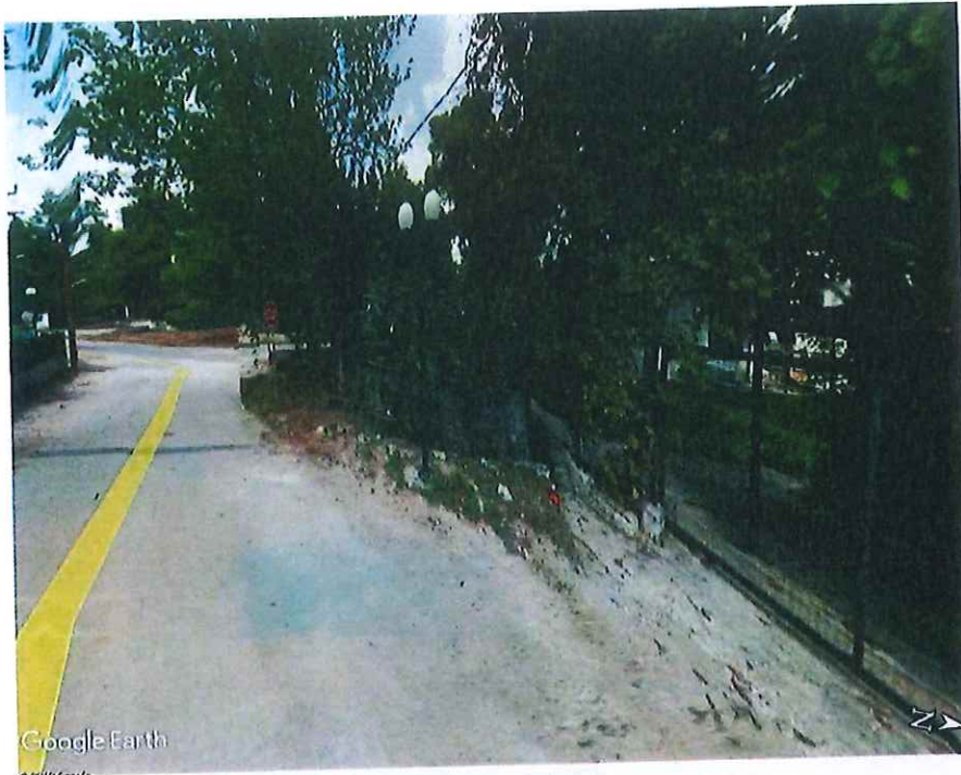
Φωτ.5.2: Άποψη διέλευσης ρέματος με τεχνικό από σκυρόδεμα (Διατομές 3-4)
