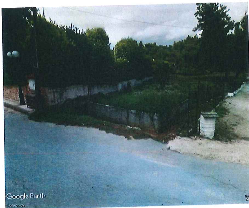
Φωτ.5.3: Άποψη διέλευσης ρέματος στο όριο ιδιοκτησίας (Διατομές 15-16)
