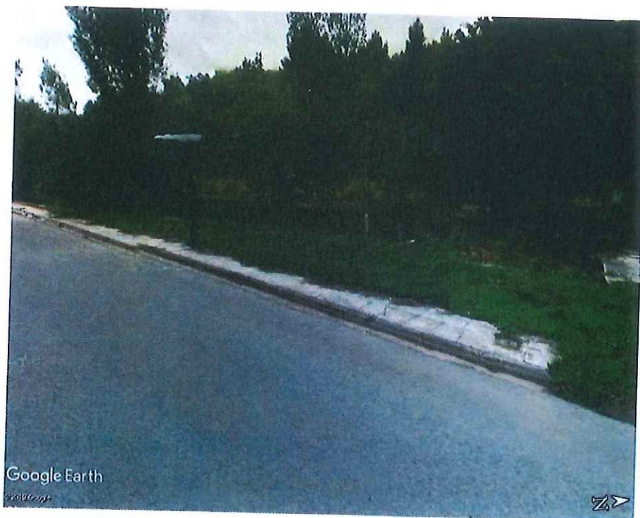
Φωτ.5.4: Άποψη διέλευσης ρέματος παραπλεύρως της οδού Μ. Αλεξάνδρου (Διατομές 31-34)
