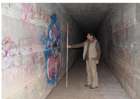
Εγκιβωτισμός του ρέματος Ορθογωνικός 2.00 x 2.80
