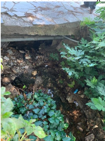
Ανάντη στην οδό Καΐρη
