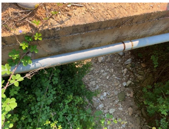
Ο φορέας της Γέφυρας
