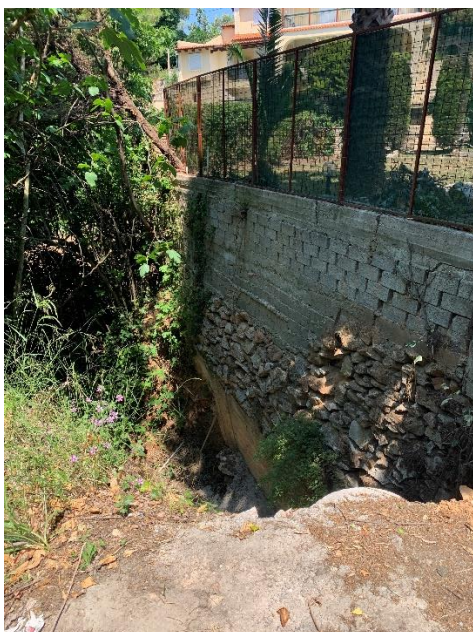
Τοίχος στην κατάντη παρειά του ρέματος
