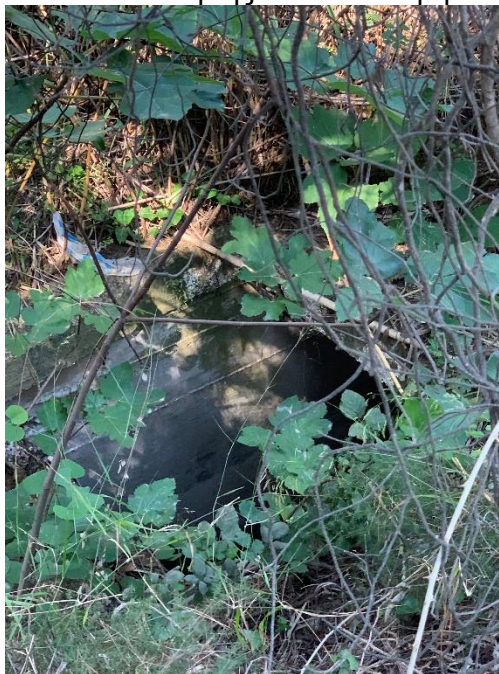
Εκβολή της τάφρου σε ορθογωνικό αγωγό
