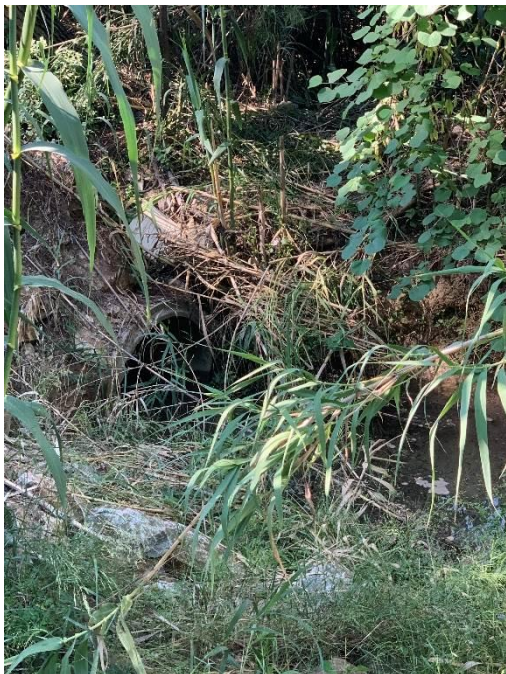
Εκβολή του Φ800 στην ανοικτή τάφρο δίπλα στην οδό Πυθαγόρα. 1.30 x 1.30.
