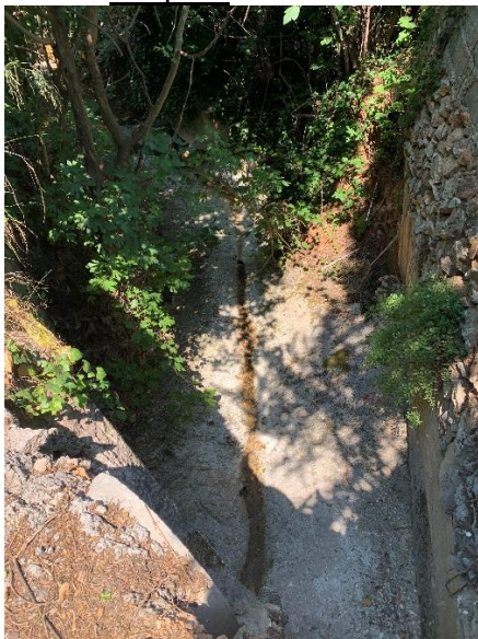
Κατάντη του Τεχνικού Δ3
