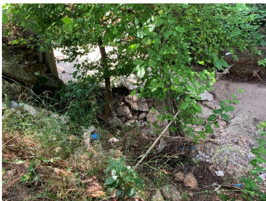
Κατάντη του τεχνικού της οδού Κέδρων
