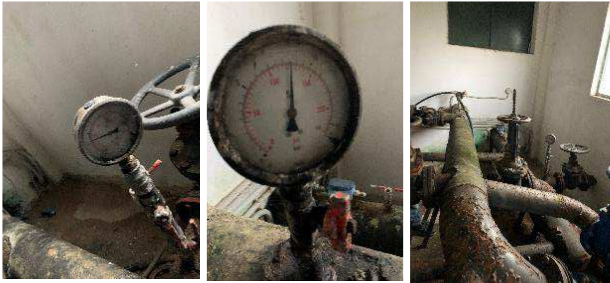
Φωτογραφία 5 : Άποψη του Α/Σ Ναυαρίνου
