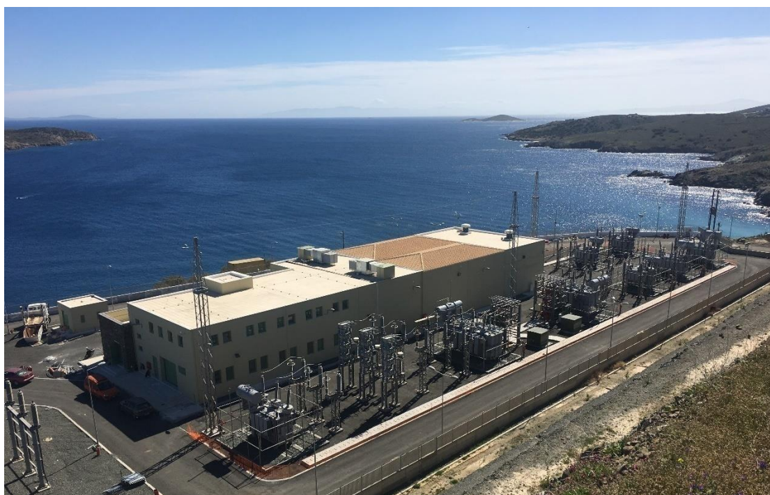
Υποσταθμός 150kV/ΜέσηςΤάσης Σύρου
