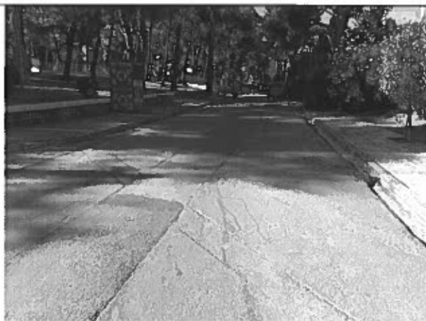
Φ06 Άποψη αποκατάστασης ορύγματος στην πλατεία Σεμέλης
