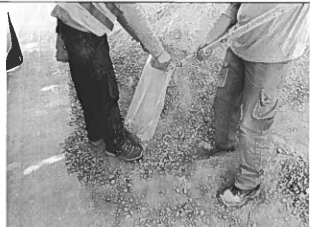
Φ26 Δειγματοληψία υλικού επίχωσης ορυγμάτων.
