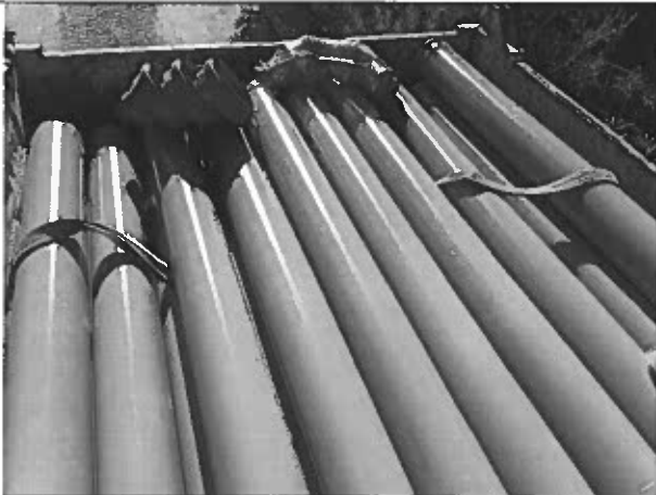
Φ25 Υλικά έργου (σωλήνες PVC).
