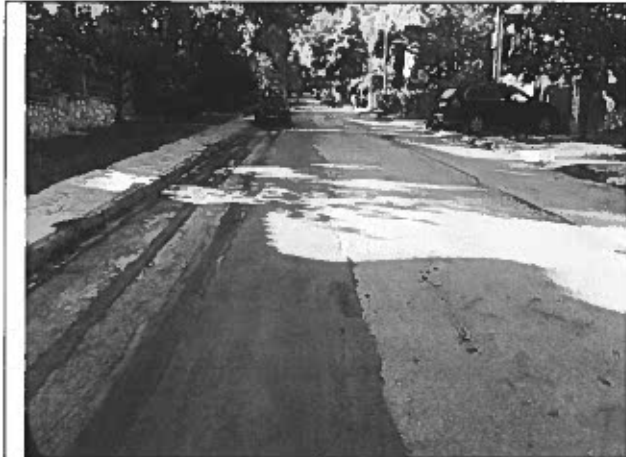
Φ09 Άποψη αποκατάστασης ορύγματος επί της οδού Αμαδρυάδων
