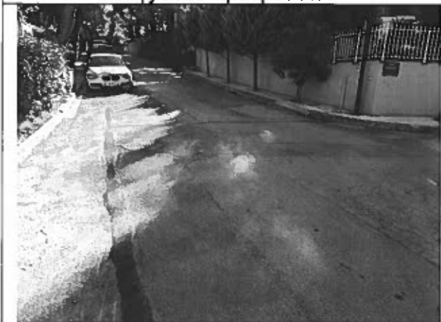
Φ11 Άποψη αποκατάστασης ορύγματος επί της οδού Χλωρίδων
