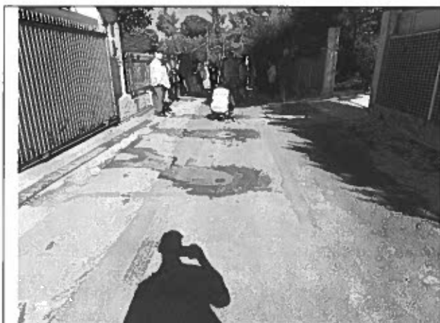
Φ13 Άποψη δειγματοληψίας ασφαλτικών επί της οδού Σαμψούντος
