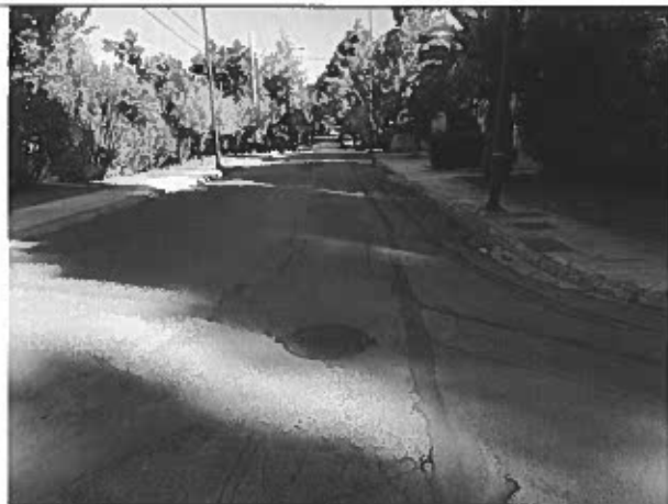
Φ05 Άποψη αποκατάστασης ορύγματος επί της οδού Αμαδρυάδων
