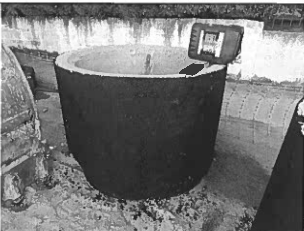
Φ27 Υλικά έργου (προκατασκευασμένα φρεάτια).
