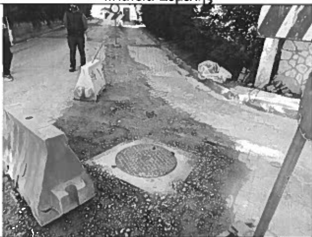
Φ08 Εργασίες σε εξέλιξη επί της οδού Θυώνης
