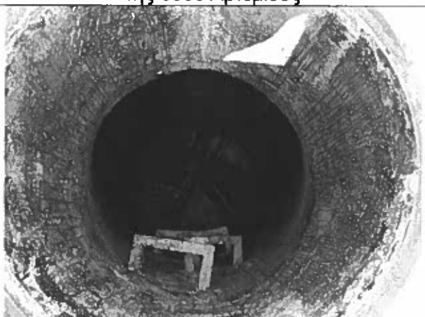
Φ12 Άποψη εσωτερικού φρεατίου
