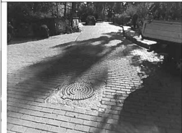
Φ03 Αποψη αποκατάστασης οδοστρώματος με κυβόλιθους επί της οδού Αθηνών
