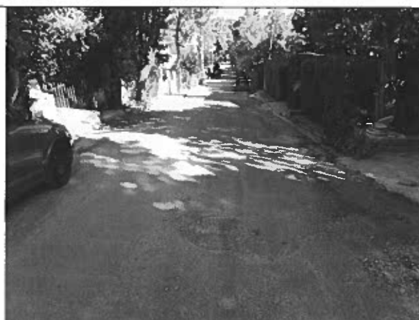
Φ22 Άποψη αποκατάστασης ορύγματος επί της οδού Μεσσήνης
