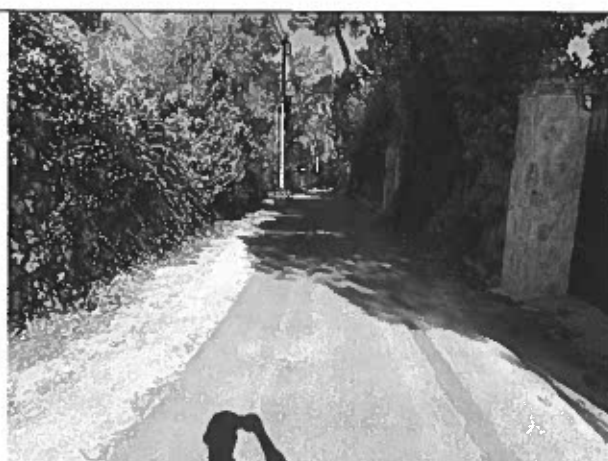
Φ14 Άποψη αποκατάστασης ορύγματος επί της οδού Σαμψούντος
