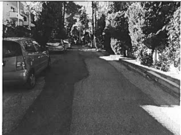
Φ10 Άποψη αποκατάστασης ορύγματος επί της οδού Αρτέμιδος
