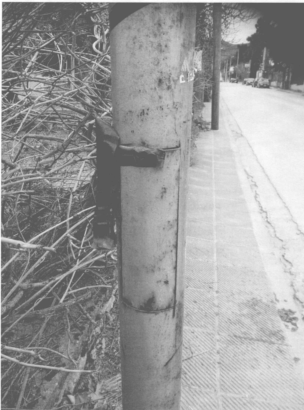
ΦΩΤΟΓΡΑΦΙΑ 15 (Είδη Υποτμήματος Γ4, Άρθρο 12/13/14) ΠΟΡΤΑ ΙΣΤΟΥ (ΛΕΩΦΟΡΟΣ ΡΟΔΟΠΟΛΕΩΣ ΔΗΜΟΤΙΚΗ ΕΝΟΤΗΤΑ ΔΡΟΣΙΑΣ)
