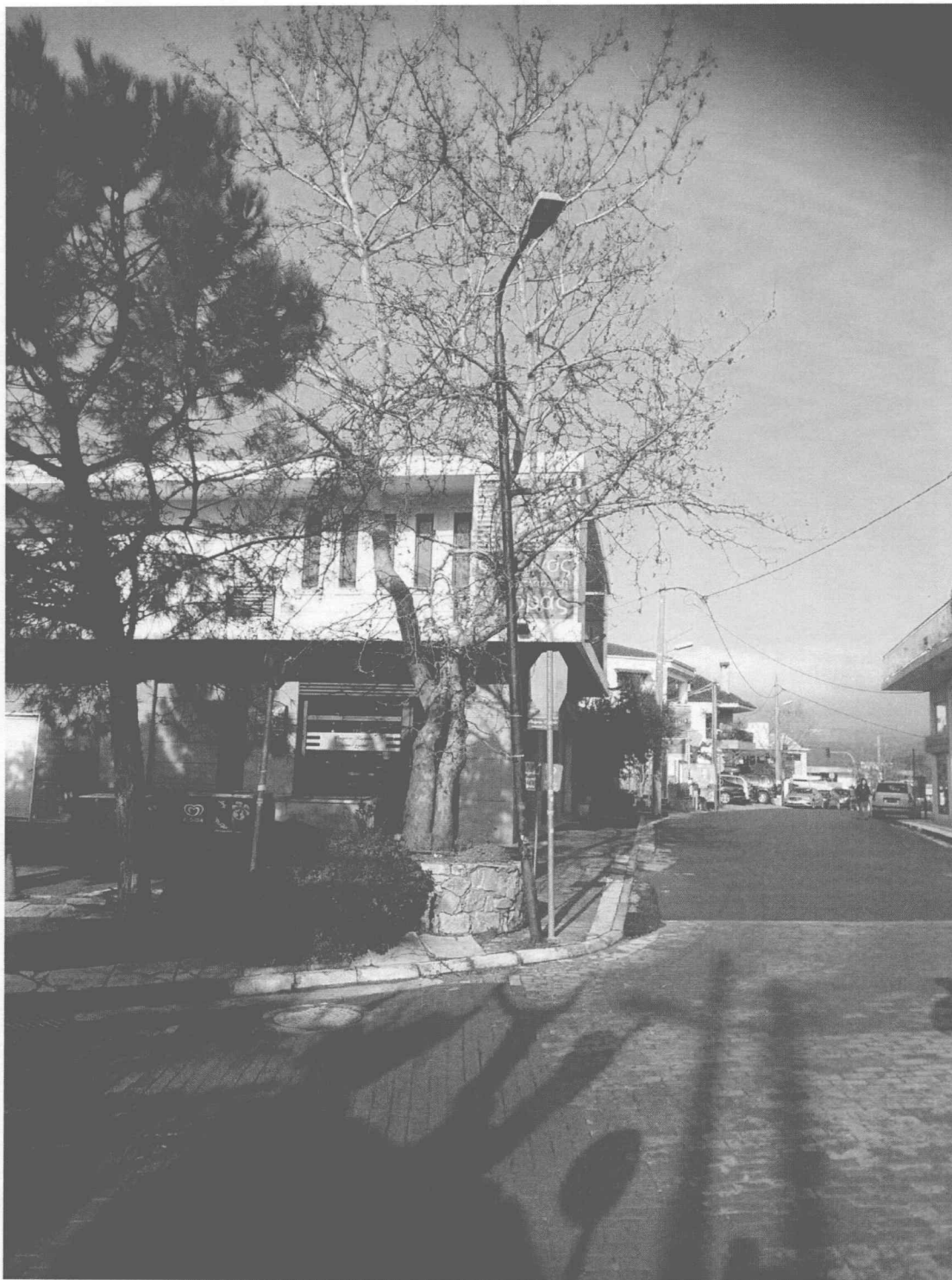
ΦΩΤΟΓΡΑΦΙΑ 11 (Είδη Υποτήματος Γ3, Άρθρο 11) ΧΑΛΥΒΔΙΝΟΣ ΙΣΤΟΣ ΟΔΟΦΩΤΙΣΜΟΥ ΎΨΟΥΣ 6 – 8 Μ - ΦΩΤΙΣΤΙΚΟ ΣΩΜΑ ΒΡΑΧΙΟΝΑ LED ( ΠΛΑΤΕΙΑ ΑΝΟΙΞΗΣ ΔΗΜΟΤΙΚΗΣ ΕΝΟΤΗΤΑ ΑΝΟΙΞΗΣ)
