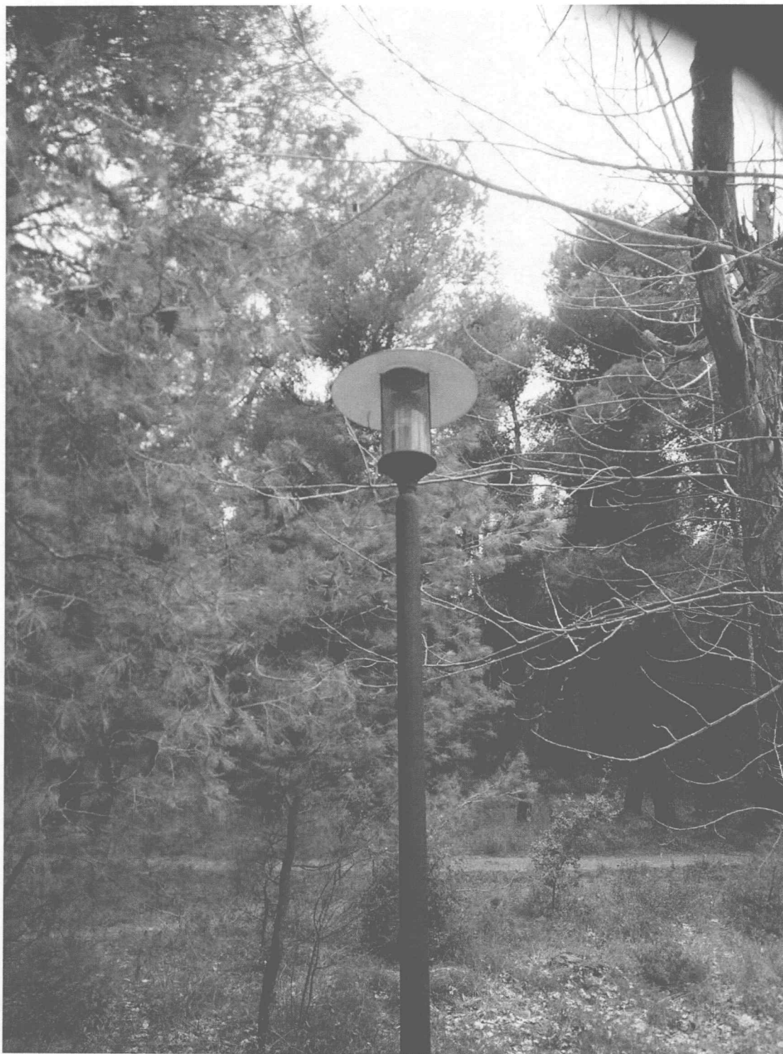
ΦΩΤΟΓΡΑΦΙΑ 13 (Είδη Υποτήματος Γ3, Άρθρο 13) ΦΩΤΙΣΤΙΚΟΥ ΣΩΜΑΤΟΣ ΚΕΦΑΛΗΣ ΑΛΟΥΜΙΝΙΟΥ ΜΕ ΑΤΣΑΛΙΝΟ ΚΑΠΕΛΟ ΓΙΑ ΛΑΜΠΤΗΡΑ ΤΥΠΟΥ E27 LED ΠΕΡΙΒΑΛΛΟΝ ΧΩΡΟΣ ΓΗΠΕΔΟΥ ΔΗΜΟΤΙΚΗΣ ΕΝΟΤΗΤΑΣ ΔΡΟΣΙΑΣ
