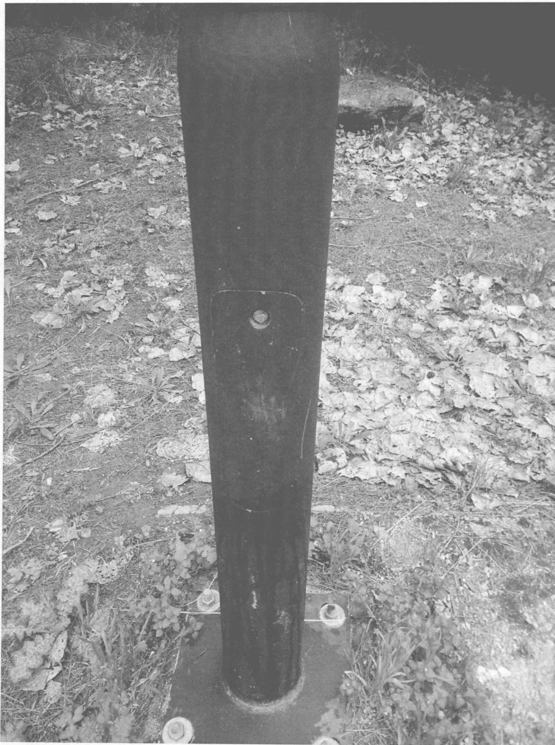
ΦΩΤΟΓΡΑΦΙΑ 16 (Είδη Υποτμήματος Γ4, Άρθρο 12/13/14) ΠΟΡΤΑ ΙΣΤΟΥ (ΠΕΡΙΒΑΛΛΟΝ ΧΩΡΟΣ ΓΗΠΕΔΟΥ ΔΗΜΟΤΙΚΗΣ ΕΝΟΤΗΤΑ ΔΡΟΣΙΑΣ)
